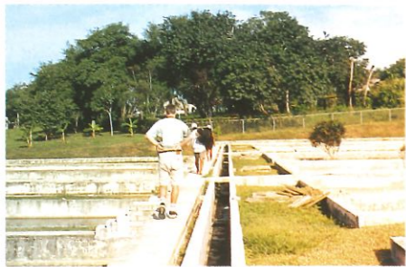
Das Kanalbewässerungssystem zwischen der oberen und unteren Reihe der Betonbecken.
